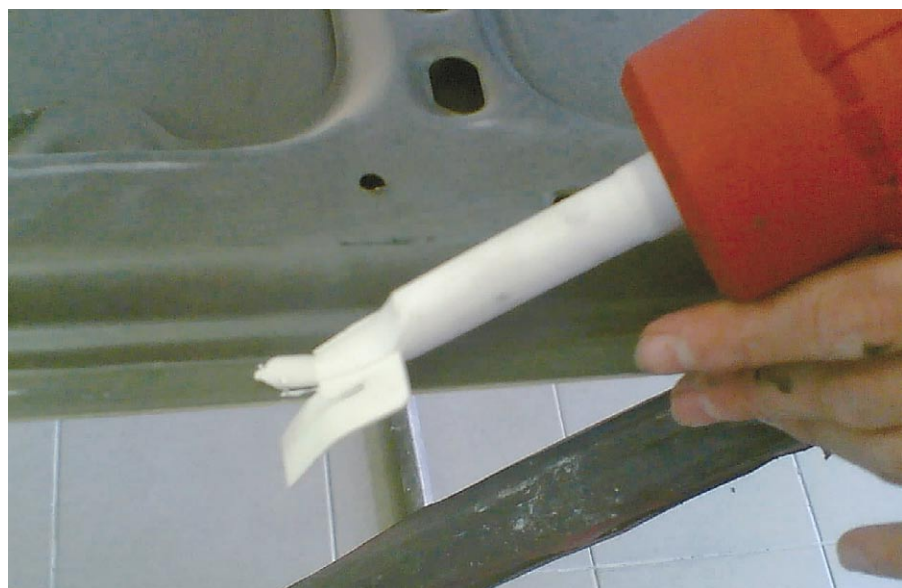
1. kép: ajtóél tömítése Terostat 9100 tömítővel
