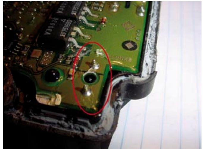
3. ábra: a szivattyú két kivezetése
