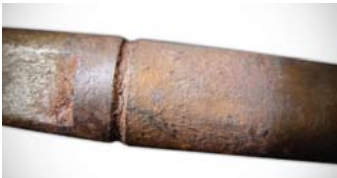
Az injektortest mély külső korróziója
