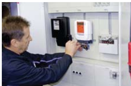
Az első digitális árammérő óra felszerelése egy német családi ház falára Félórák mintavétel csak digitális mérőórákkal végezhető
