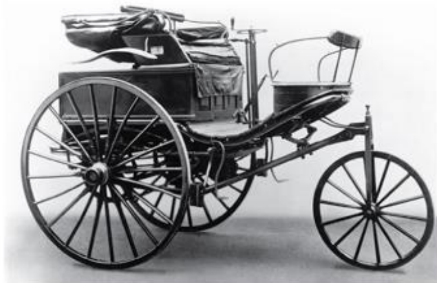
A Patent-Motorwagen első sorozatban gyártott változata 1888-tól. Az 1,5 lóerős motorral 16 km/h sebességet lehetett elérni, akkori ára 3000 márka volt
