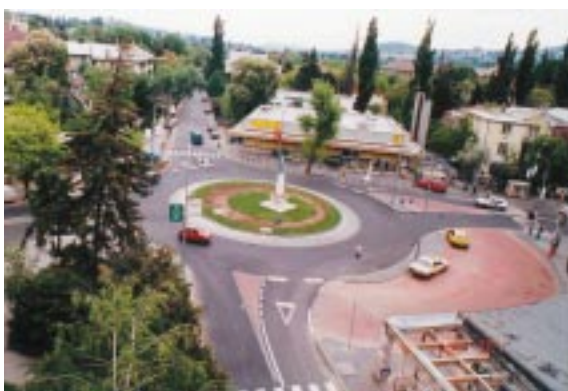
Kisebb városi csomópontokban is létrehozhatók egészen egyszerű, olcsó, nagy áteresztőképességű és a lámpás kereszteződésekhez képest balesetstatisztikailag is kedvezőbb körforgalmi csomópontok
